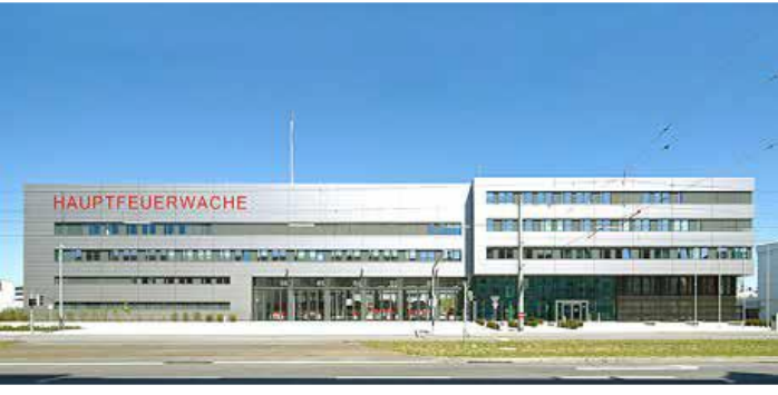
Dachbegrünung Hauptfeuerwache Mannheim
